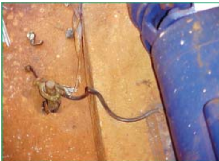
Figura 2 – Para sua segurança toda máquina elétrica deve ser aterrada
