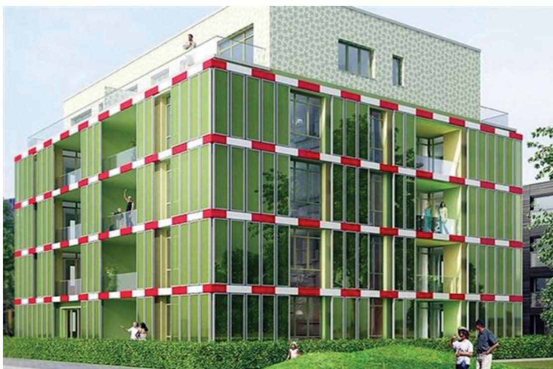
Por isso existe um sistema responsável por bombear a água em círculos para garantir que as plantas fiquem expostas à radiação solar direta por pouco tempo. Do contrário, as chamadas "microalgas" morreriam devido ao calor excessivo. Todo o processo é um espetáculo para quem observa a fachada. De vez em quando dá até para ouvir as bolhas de ar.
